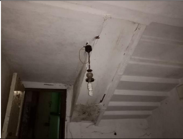
Фото № 13 – Внутреннее состояние помещения
