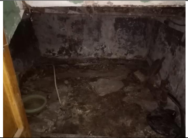
Фото № 14 – Внутреннее состояние помещения
