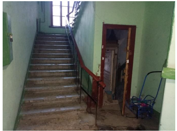
Фото № 8 – Вход в помещение с лестничной клетки
