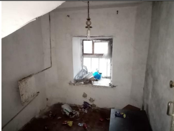
Фото № 9 – Внутреннее состояние помещения
