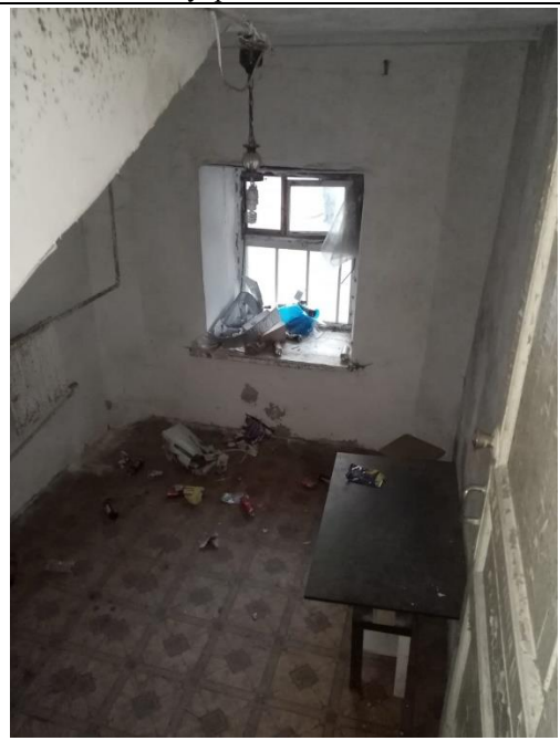
Фото № 12 – Внутреннее состояние помещения
