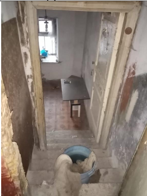
Фото № 11 – Внутреннее состояние помещения
